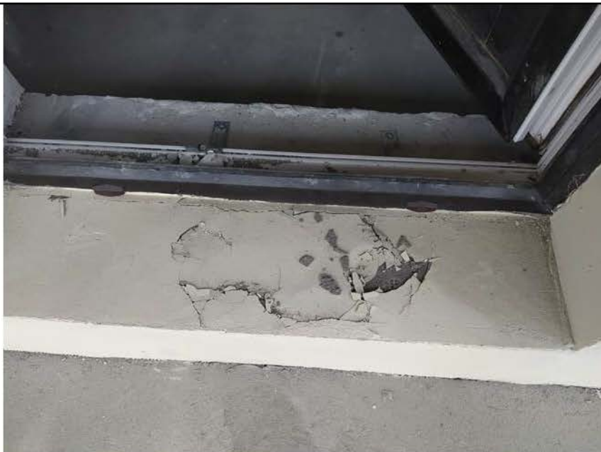
Фото №49. Сколы и трещины в покрытии конструкции порога пола лоджии.
