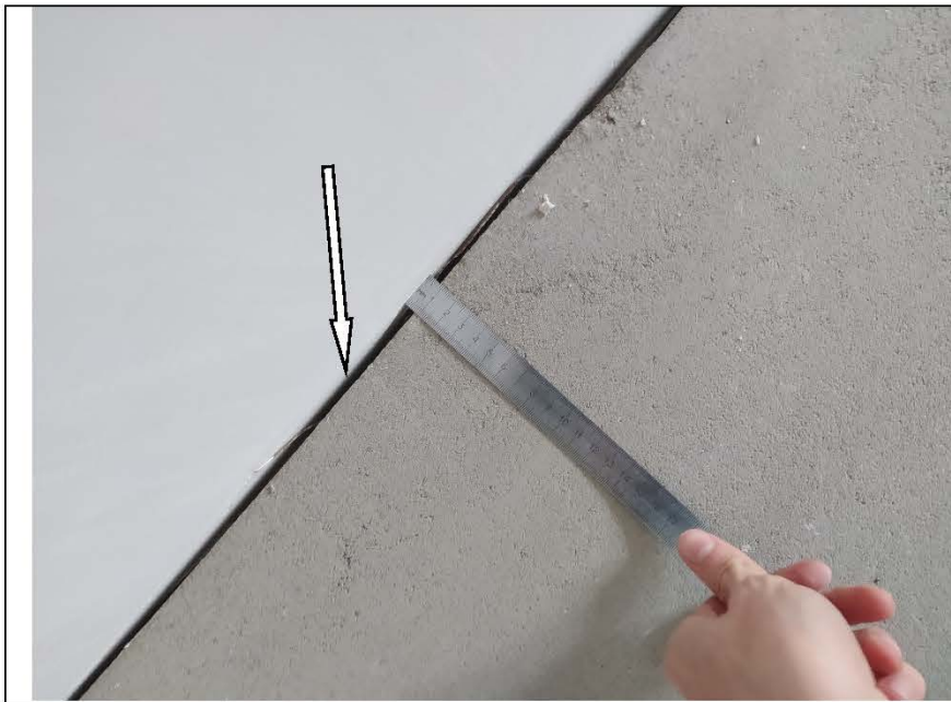
Фото №31. Отсутствие изолирующего материала в изолирующих швах в местах примыкания стен гостиной и стяжки пола.
