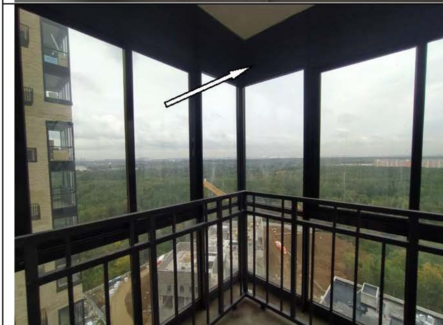
Фото №45. Не удалена защитная пленка с лицевой поверхности профилей оконного и дверного блока на лоджии.
