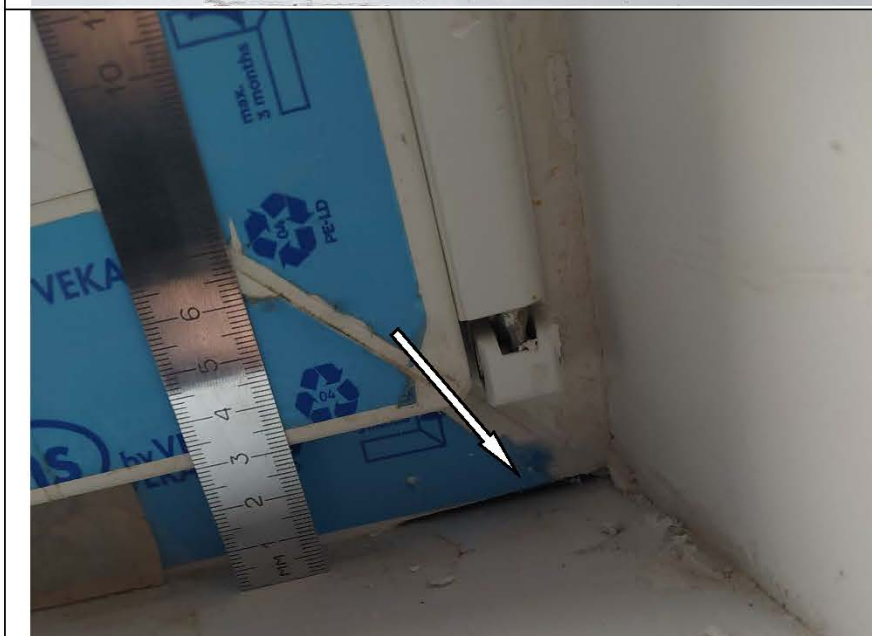
Фото №41. Оконный блок в месте примыкания к подоконной доске в спальне имеет щель.
