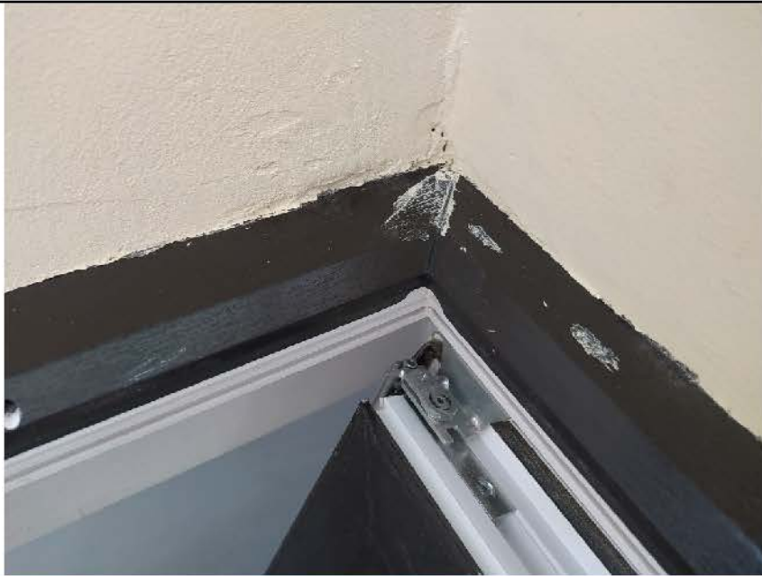
Фото №46. Дверная коробка поджии выполнен с дефектами (разводы и брызги малярных составов).
