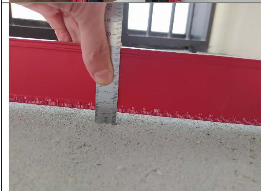
Фото №11. Измерение уровня стяжки пола на лоджии.
