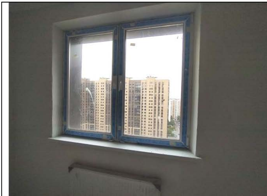
Фото №43. Не удалена защитная пленка с лицевой поверхности профилей оконного и дверного блока в гостиной.
