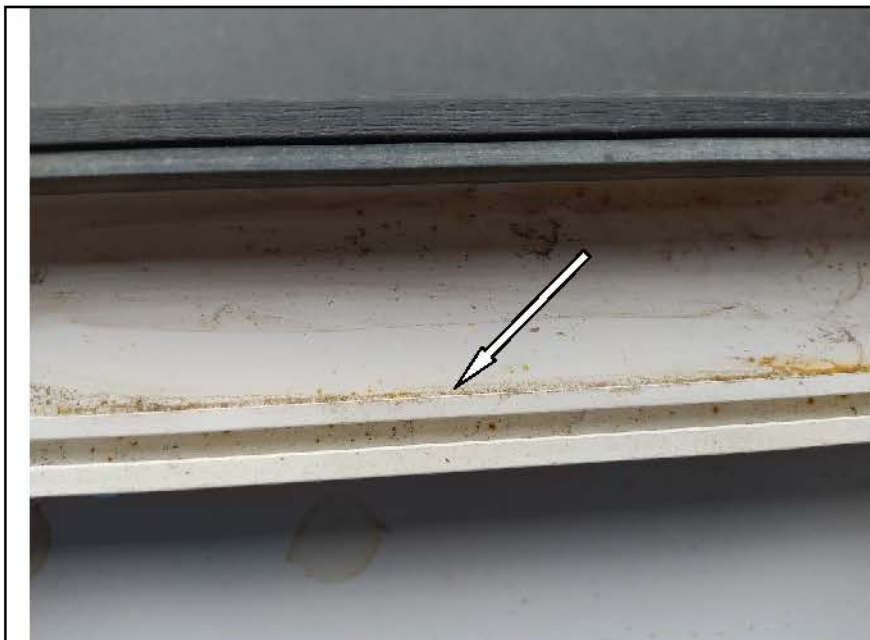
Фото №37. Окалины на профиле ПВХ оконного блока в гостиной.
