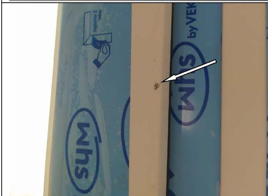
Фото №39. Механическое повреждение в виде притертости на профиле ПВХ оконного блока на кухне.
