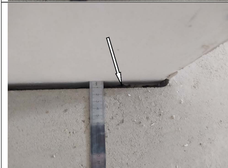
Фото №33. Отсутствие изолирующего материала в изолирующих швах в местах примыкания стен прихожей и стяжки пола.
