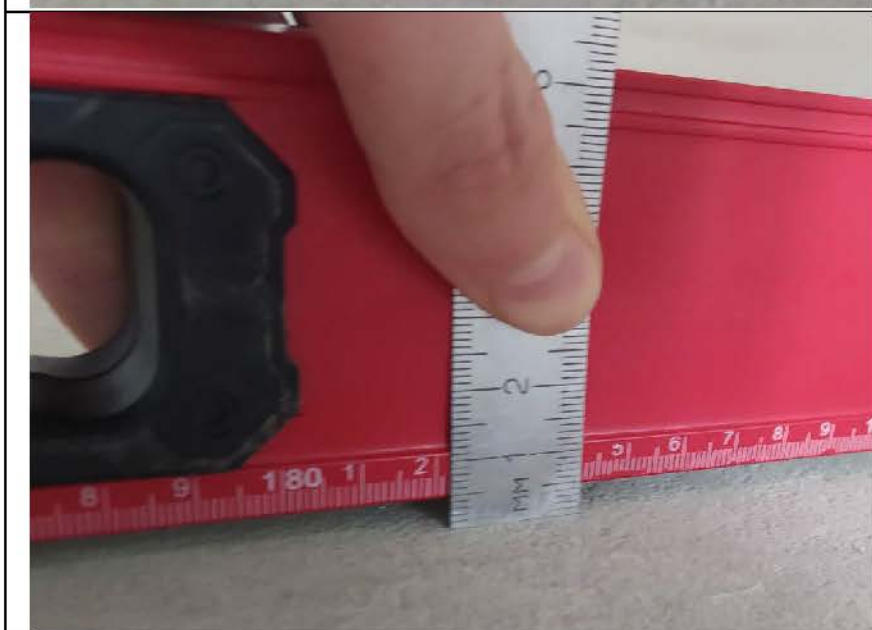
Фото №12. Измерение уровня стяжки пола в кухне.
