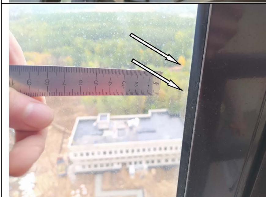
Фото №36. На стеклопакете оконного блока ПВХ на лоджии имеется дефект (окалины).
