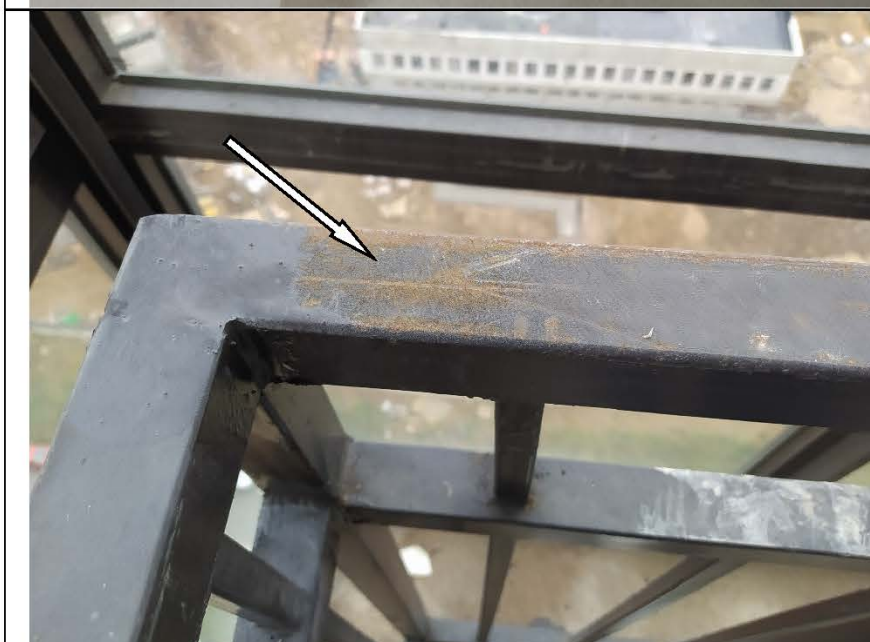
Фото №35. Поверхностная коррозия металлического профиля ограждающей конструкции на лоджии.
