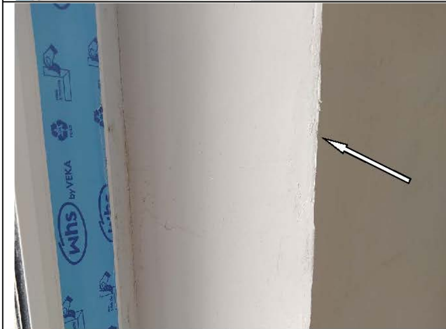
Фото №14. Неровность очертания шпаклеванных поверхностей оконных откосов в гостиной.
