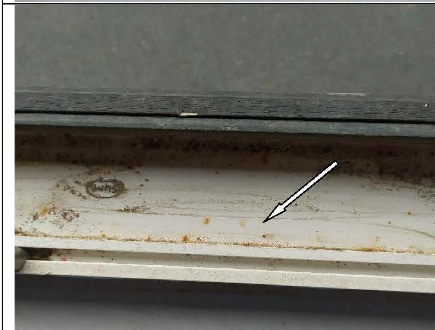
Фото №38. Окалины на профиле ПВХ оконного блока в спальне.
