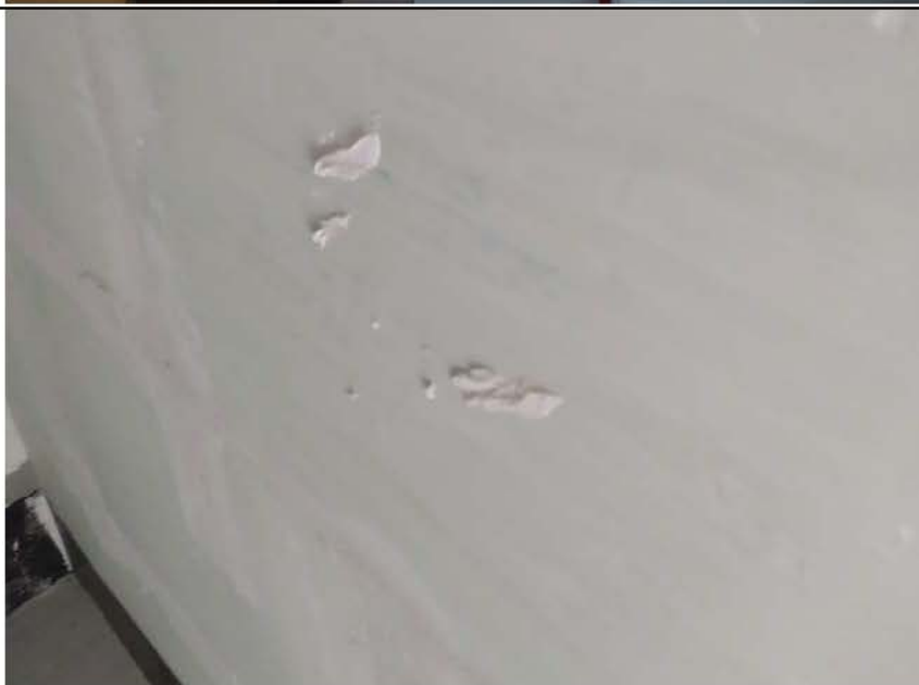
Фото №48. Загрязнение пазогребневых плит в ванной комнате отделочными растворами.
