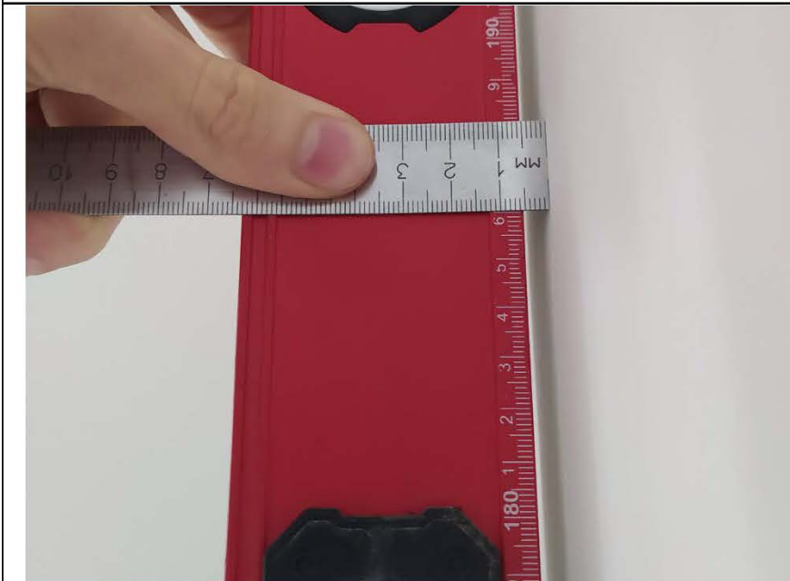
Фото №8. Измерение уровня стен в кухне.
