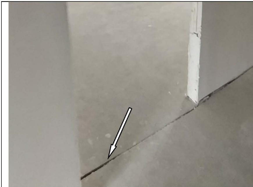
Фото №34. Швы готовой стяжки пола в прихожей выполнены неверно.
