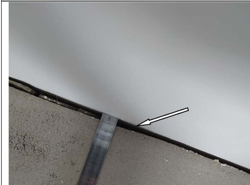
Фото №32. Отсутствие изолирующего материала в изолирующих швах в местах примыкания стен спальни и стяжки пола.
