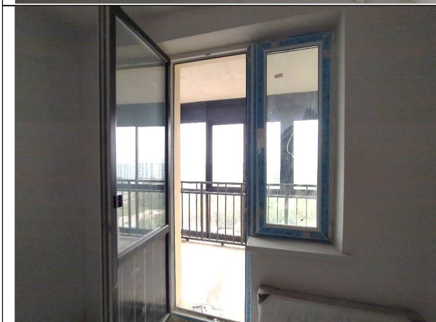
Фото №42. Не удалена защитная пленка с лицевой поверхности профилей оконного и дверного блока на кухне.
