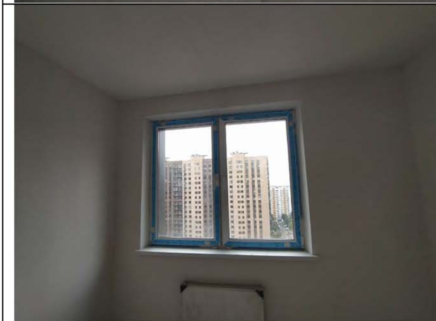
Фото №44. Не удалена защитная пленка с лицевой поверхности профилей оконного и дверного блока в спальне.
